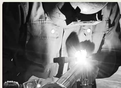
Manual welding Ручная сварка
